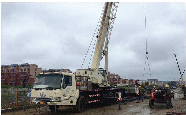
↑珲春城市地下综合管廊一期工程进展顺利,东关路地下管廊全面开工建设。据了解,一期工程全长5.26公里。其中,东关路地下综合管廊起于库克纳河南岸南大街,止于渤海大街,全长1.80公里。图为东关路地下管廊施工现场。 本报记者 张凯棋 摄
