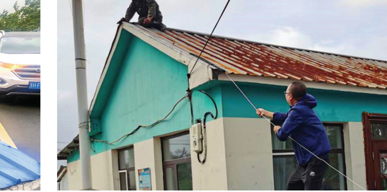
↑敬信镇村民与机关干部修缮破损房屋 本报记者 张凯棋 摄
