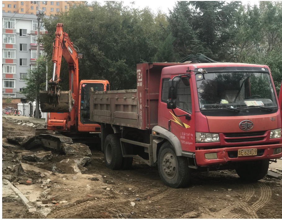
↑图为珲春市河南街道永盛社区老旧小区改造项目现场 本报记者 张雪楠 摄
