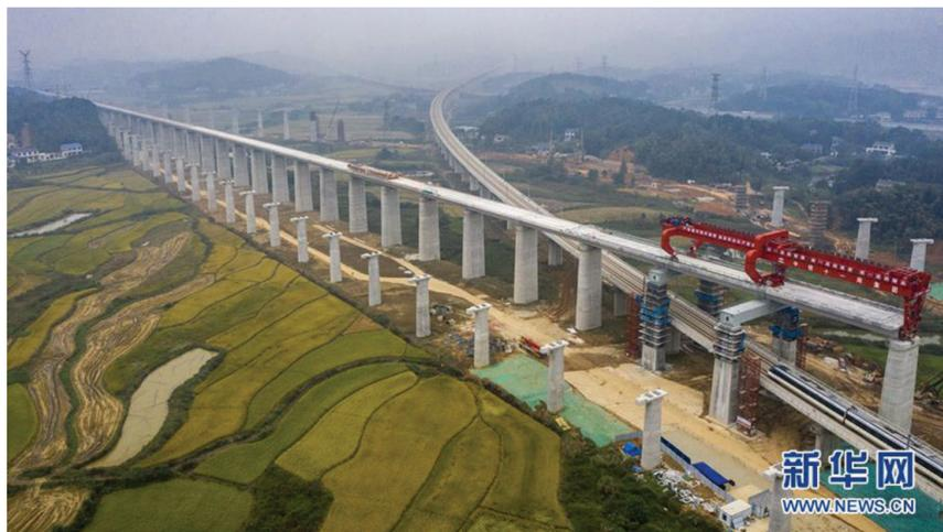
10月13日,一列火车从常益长铁路黄桥大道特大桥上跨石长铁路山联络线箱梁架桥施工现场通过(无人机照片)。10月13日,经过连续3个凌晨3次封锁要点施工,常(德)益(阳)长(沙)铁路跨上跨已运营的石(门)长(沙)铁路山联络线3榀箱梁顺利架桥完成,常益长铁路架桥施工突破一个重大风险卡控点。常益长铁路正线全长约157公里,设计时速为350公里,是国家“八纵八横”高速铁路网中厦门至重庆、呼和浩特至南宁两条大通道的重要组成部分。
