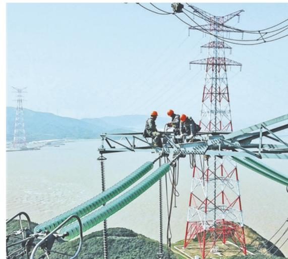
10月24日,检修人员在跨海输电高塔上进行检修工作(无人机照片)。近期,浙江省国网舟山供电公司组织人员对浙江舟山500千伏联网输电线路洛远线进行综合检修,这是该线路自2019年通电投运以来的首次检修。检修消缺工作的完成将提高舟山联网输电线路的运行可靠性。新华社记者 徐昱 摄
