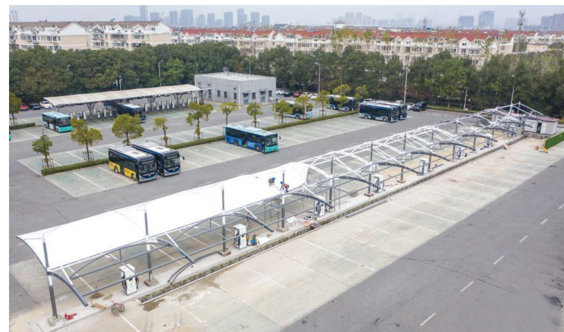
这是近日拍摄的正在建设的苏州市莲花停保场充电站(无人机照片)。近年来,江苏省苏州市积极倡导绿色发展,低碳节能理念,大力推进电动汽车充电设施建设。据介绍,截至2020年11月底,接入苏州市新能源汽车及充电设施监测平台的充电设施运营商家达到23家,充电桩(点)964座、交直流充电桩7675台,形成小区、商场、高速公路服务区等公共充电网络全覆盖。新华社记者 李博 摄
