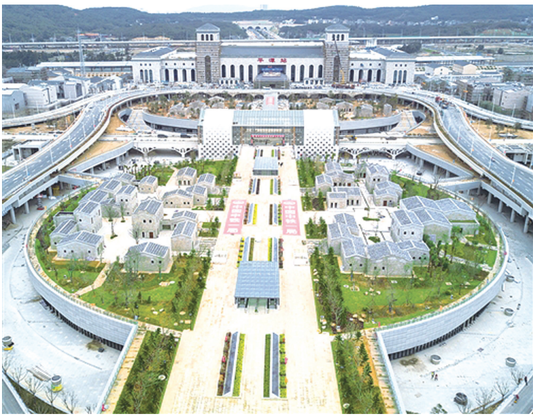
↑这是在进行收尾阶段施工的福平铁路平潭一体化综合交通枢纽(12月7日摄,无人机照片)。目前,福平铁路平潭一体化综合交通枢纽正在进行收尾阶段施工,即将投入使用,为福平高铁于12月底通车运营、平潭国际旅游岛正式进入高铁时代奠定基础。福平铁路平潭一体化综合交通枢纽由中铁一局承建,汇集高铁、公交、出租车、网约车、私家车等多种交通出行模式,为旅客提供“零换乘”和“无缝衔接”体验。 新华社记者 宋为伟 摄
