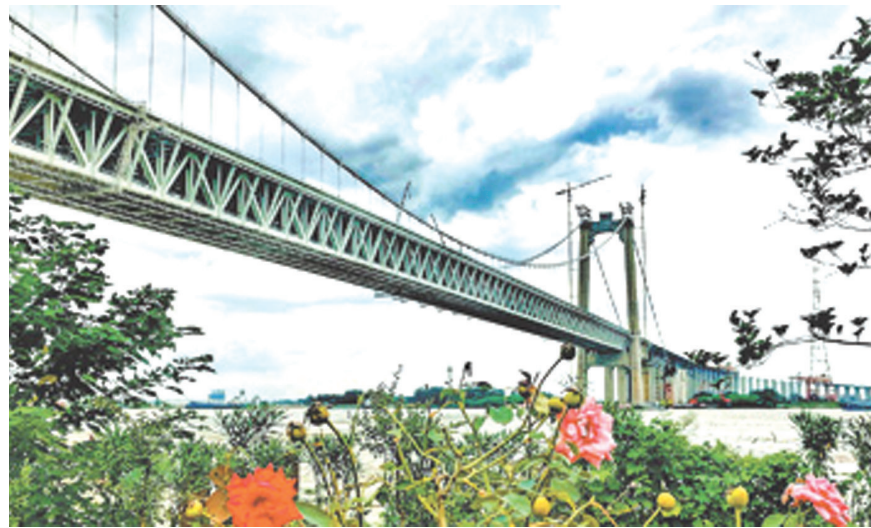
近日,全长6.4公里的五峰山长江大桥建成通车,连接江苏连云港和镇江的连镇高铁全线开通。设计标准为客运专线,设计时速250公里。北段连云港至淮安段已于2019年12月开通运营。图为开通前的五峰山长江大桥。 人民日报记者 王伟健 崔永兴 摄
