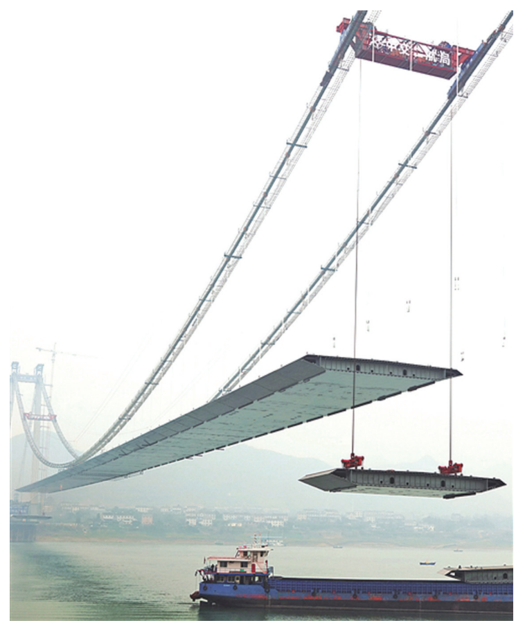
11月4日,湖北省宜昌市伍家岗长江大桥加速安装主跨钢箱梁。该项目采用业内首创的“两跨对接、焊架同步”新技术,南北两端同时吊装焊接。目前项目已完成安装量的三分之二。刘卫东 摄
