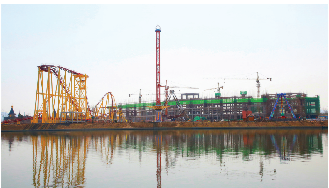
总投资3亿元的珲春渤海明珠欢乐谷项目有序复工且进展顺利,预计“十一”期间对外开放。该项目位于珲春河江心岛,共分为四大主题功能区,是集游玩、度假、休闲、餐饮、购物、住宿于一体的多功能主题景区。图为项目施工现场。
