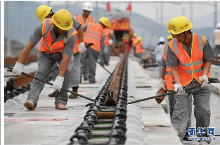
6月22日,中铁十一局的施工人员在杭绍台铁路上进行铺轨作业。当日,在杭绍台铁路温岭站施工现场,随着最后一根钢轨平稳在无缝道床上铺设到位,我国首条民营控股高铁杭绍台铁路全线铺轨贯通,为年底开通运营奠定基础。杭绍台铁路连接浙江杭州、绍兴和台州三地,线路设计时速350公里。
