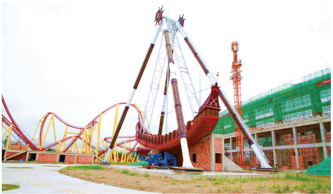
珲春市渤海明珠欢乐谷项目进展顺利,计划2022年6月对外营业。目前,该项目过山车、飞行塔、大摆锤、豪华海盗双层旋转木马等室外设施部分已进入安装调试阶段,计划今年8月份对外营业。图为项目现场。
