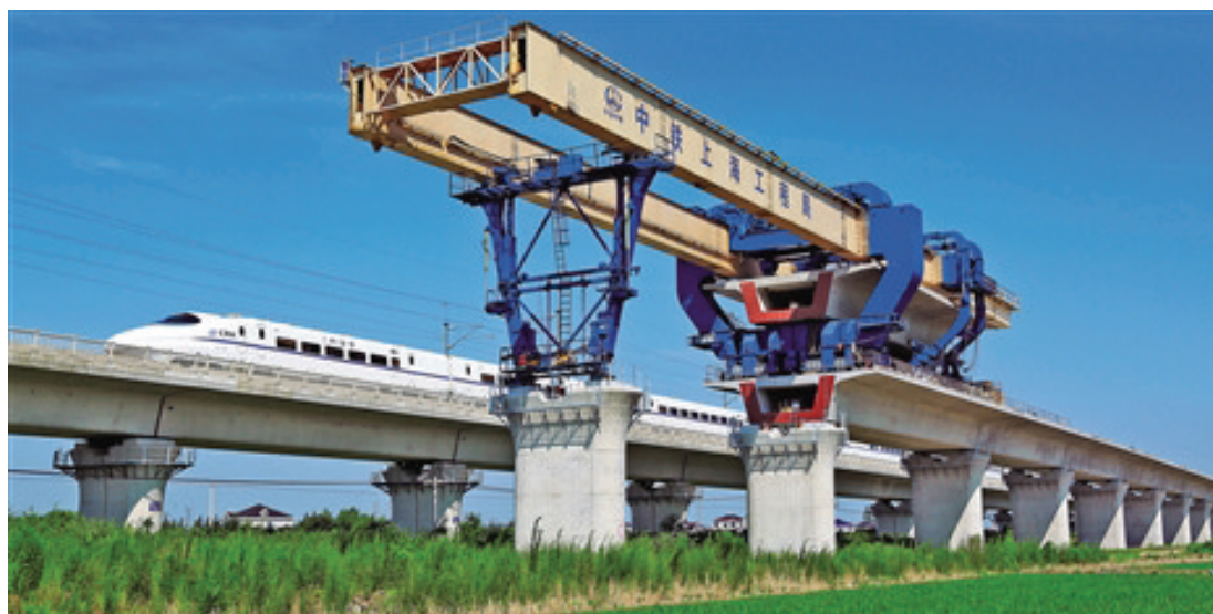
↑南沿江城际铁路是沪宁间第二条城际铁路，是长江经济带综合立体交通走廊的重要组成部分，计划于2023年4月建成通车。图为项目施工现场。王慧 摄(中经视觉)
