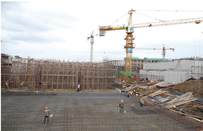
珲春市边境经济合作区污水处理厂项目进展顺利。该项目总投资37336.18万元,总用地面积(厂区内)86433.44平方米。目前,单体建筑已开工建设18个,污泥脱水间、水解酸化池南侧池体等基础基本完成。图为项目施工现场。 本报记者 崔美玲 摄
