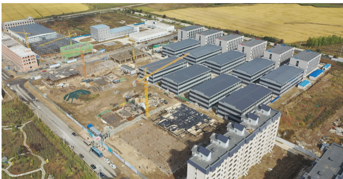
珲春市马川子乡二期项目进展顺利。该项目建筑面积51121平方米,用地面积52812平方米,计划建设C、D、E型工业厂房,厂房将用于服装加工制造及印染、面辅料、拉链等相关配套。项目建成后,将与国内知名服饰品牌签署战略合作协议,加快投入生产。届时,将有效解决当地劳动力就业,助力地方经济高质量发展。图为项目施工现场。
