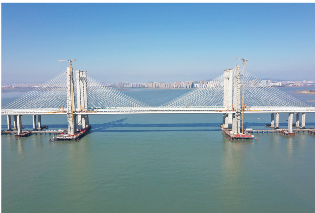
11月30日拍摄的新建福建铁路泉州湾跨海大桥主桥(无人机照片)。
