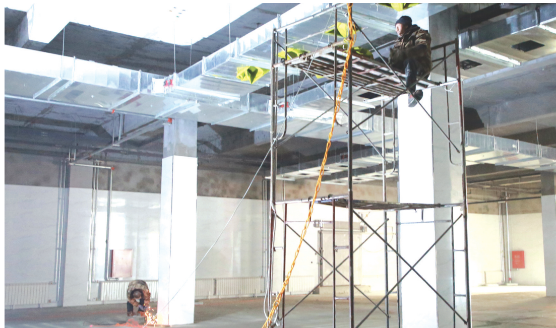
珲春市贸易进口商品落地加工产业园区项目进展顺利。该项目于3月21日开工建设,目前,8栋工业厂房和1栋办公楼主体已封顶,1、2、3、4、5号厂房正在进行内部装修,预计12月末,1、4、5、7号厂房可交付使用。图为工人进行吊棚隔断施工。 本报记者 崔美玲 摄
