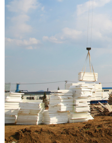
图为吉林珲春海洋经济示范区冷链物流基地示范项目施工现场。 本报记者 崔美玲 摄
