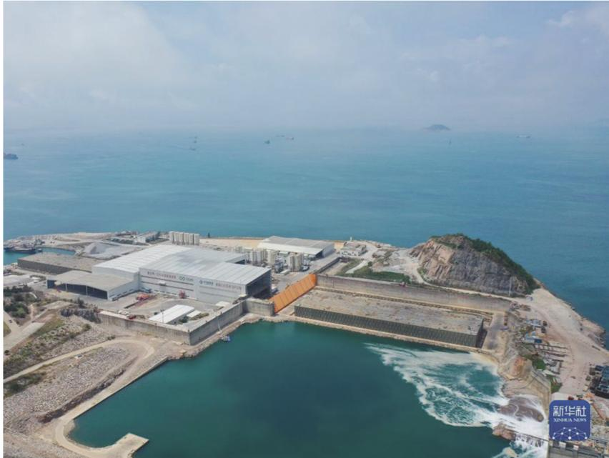
日前,深中通道E20管节在中交四航局珠海牛头岛沉管智慧工厂进行浇筑,完成一次舱室的E19管节即将横移到深水区,完成卸驳的E21管节正待浇筑,3节沉管齐聚牛头岛。这3节沉管均为标准管节,分别长165米、宽46米、高10.6米,每节沉管由2255个独立的仓格组成,混凝土浇筑方量约2.9万立方米,浇筑完成后的每节沉管重达8万吨。
