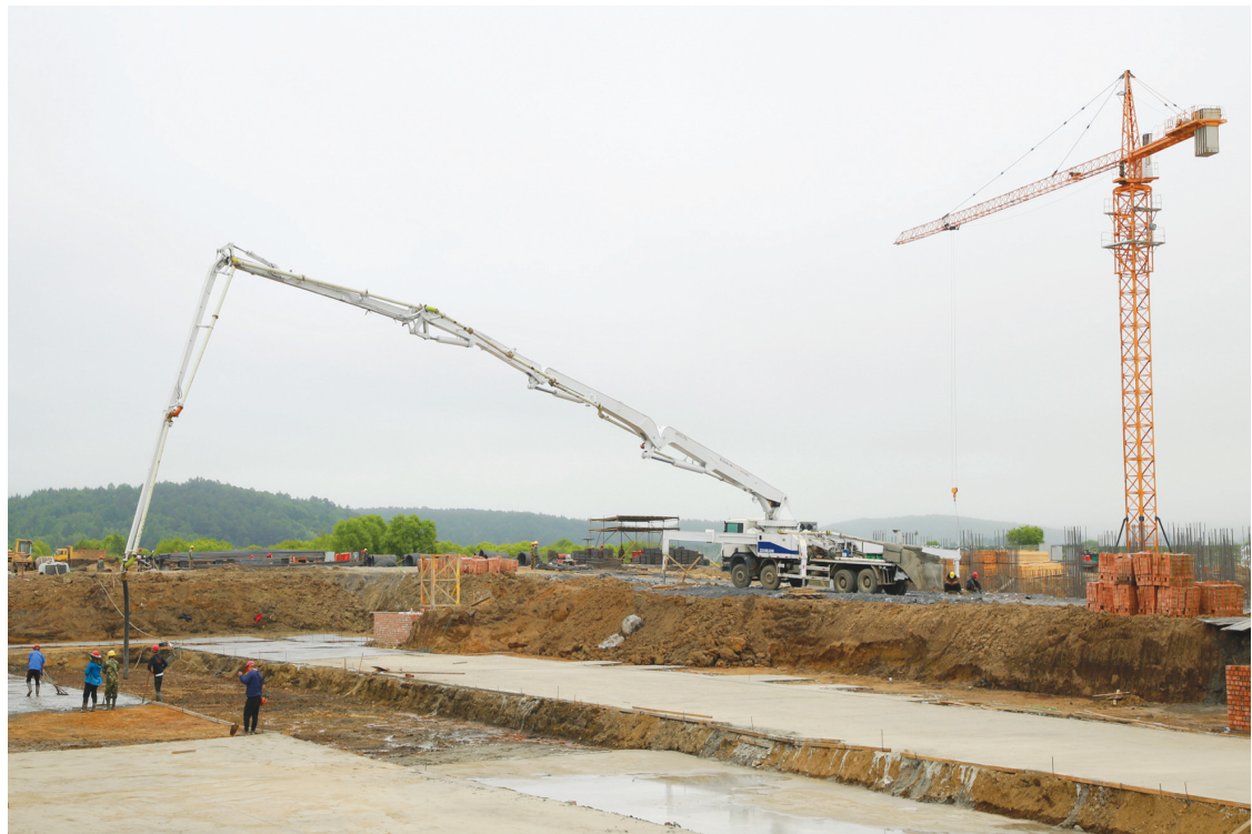
珲春市延边黄牛集中繁育养殖示范园区项目进展顺利。该项目总投资9.77亿元,主要建设综合科研区、生产繁育区、饲料加工区、粪污处理区等四个功能区,配套建设各类基础设施。项目建成后,将有效促进全市黄牛养殖产业快速发展。图为项目施工现场。 本报记者 崔美玲 摄
