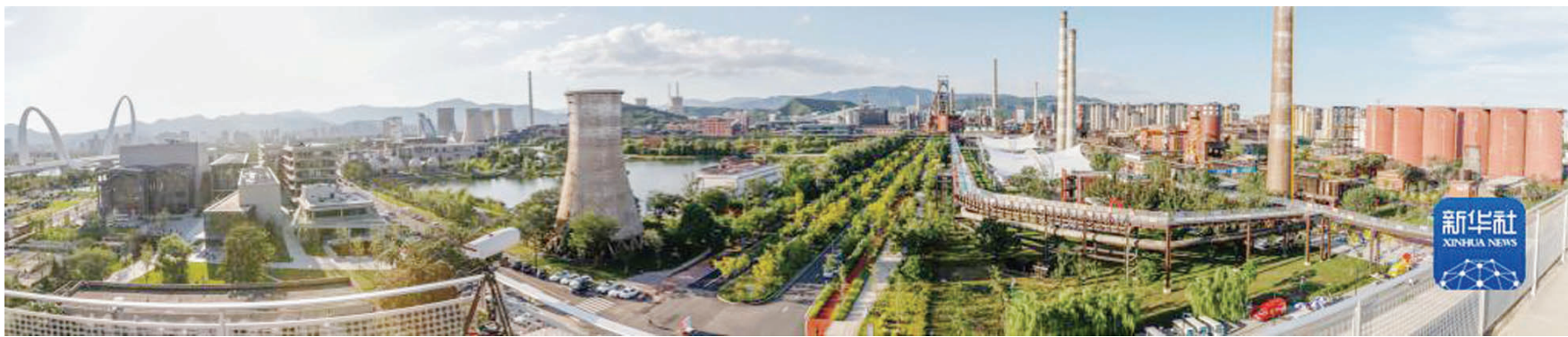
↑这是2021年9月6日拍摄的首钢园(全景照片)。
