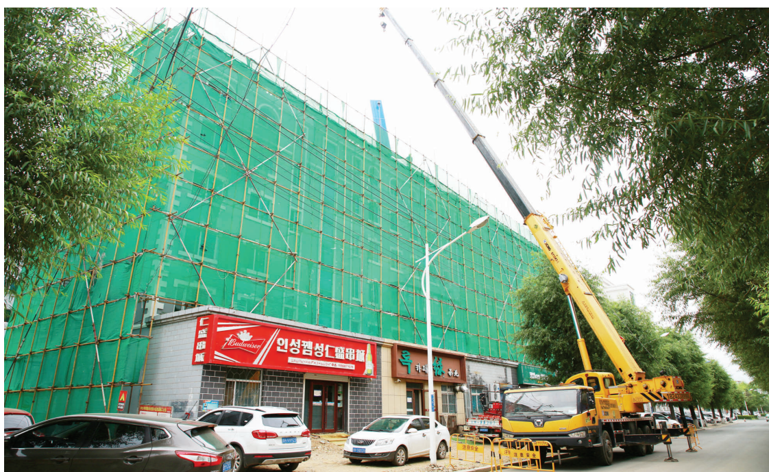
珲春市加快推进老旧小区改造,让老旧小区旧貌换新颜,提升市民的幸福感和获得感。图为老旧小区改造现场。 本报记者 崔美玲 摄
