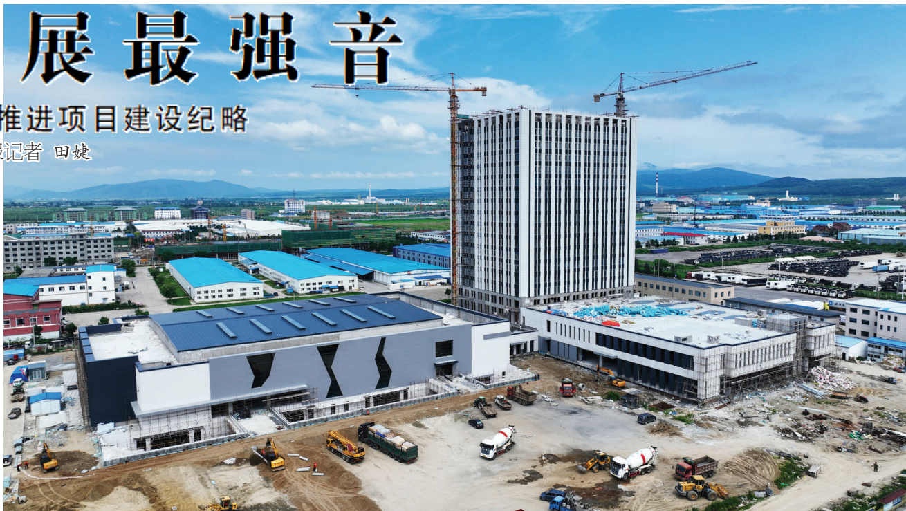
珲春东北亚跨境互市电商产业孵化中心项目施工现场。
