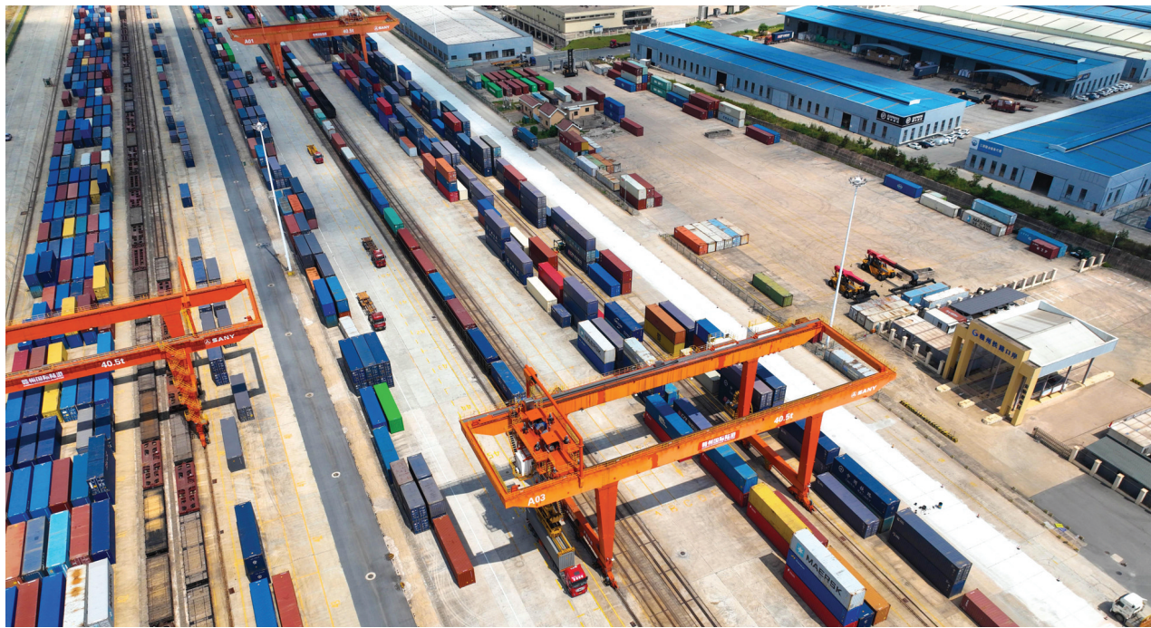
7月21日,在江西省赣州国际陆港货场,龙门吊起吊正在吊运集装箱货柜,货车装卸作业来来往往,现场呈现一派繁忙景象。
