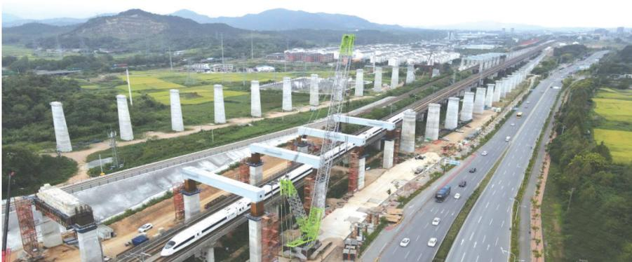
↑9月3日,一列高铁列车经过完成吊装后的门式墩钢盖梁(无人机照片)。当日,由皖赣铁路安徽公司承建、中铁十一局施工的池(州)黄(山)铁路白沙铺特大桥上行单线跨宁安高铁门式墩钢盖梁吊装完成,为后续工程施工提供了保障。池黄铁路全长约125公里,设计时速350公里,是武汉(杭州)快速铁路通道的重要组成部分。
