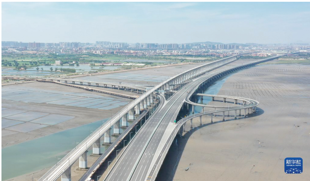
↑这是9月2日拍摄的新建福厦铁路泉州湾跨海大桥(无人机照片)。
