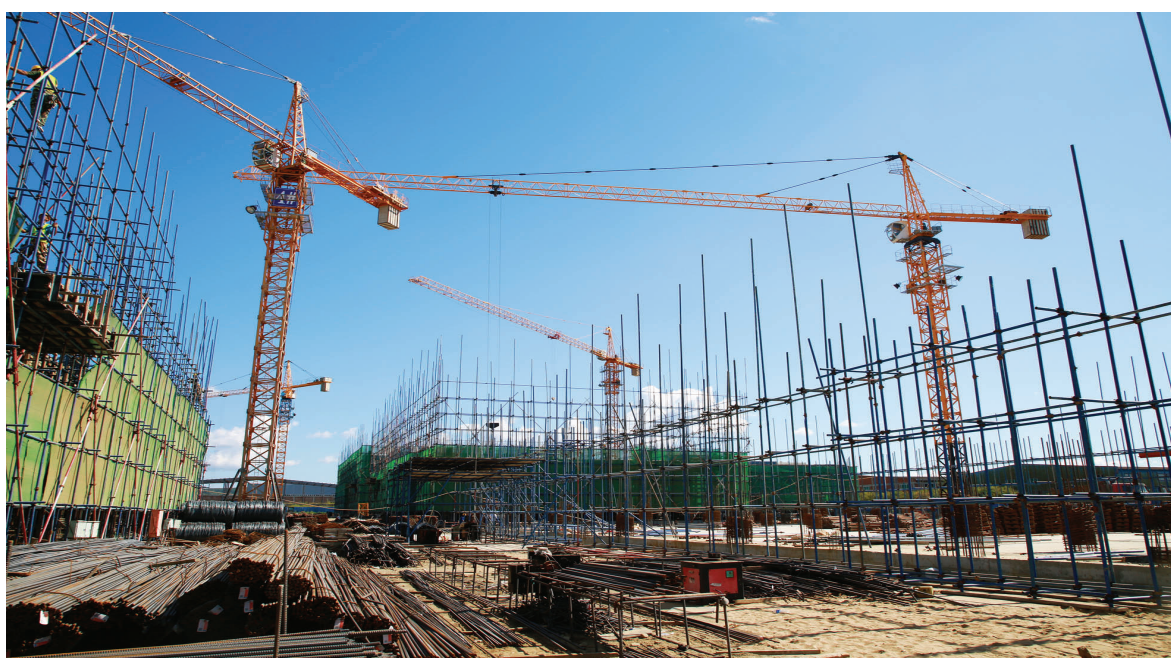
珲春海洋经济功能食品产业园项目进展顺利。该项目总投资约3.2亿元,于今年6月开工,预计2023年8月完工。项目建成后,可有效促进珲春功能食品产业发展,实现产业高级化、产品高端化、品牌驰名化,助力地方经济发展。图为项目施工现场。 本报记者 崔美玲 摄
