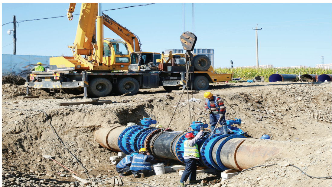
图为滨河北路输水管线施工现场。
