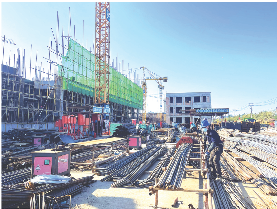
吉林珲春海洋经济示范区冷链物流基地示范项目进展顺利。该项目投资约6亿元,于2021年10月开工建设,主要建设海洋经济产业综合类标准化厂房及相关配套的公用工程。项目建成后,将降低中小企业创业成本,满足各类企业发展需求,拉动形成产业集群。因为项目施工现场。
