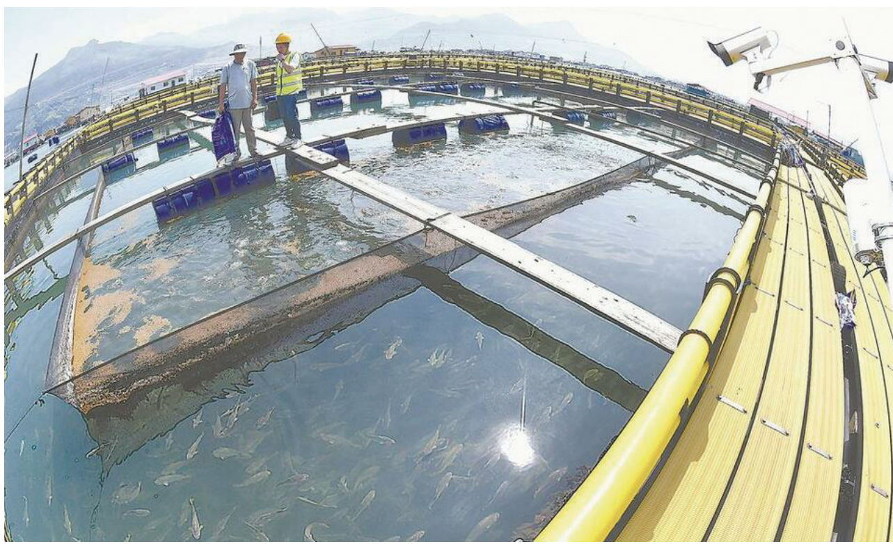
近年来,宁德市不断推动数字技术与海洋产业融合发展,加速推进5G智慧海洋建设,打造5G智慧海洋样板区。图为位于蕉城区三都澳的“5G+AI智慧海洋”新型养殖渔排上安装的5G+AI智慧监控系统,可实现渔排高清视频画面实时回传,满足大黄鱼养殖高质量发展需求。福建日报记者 林辉 摄
