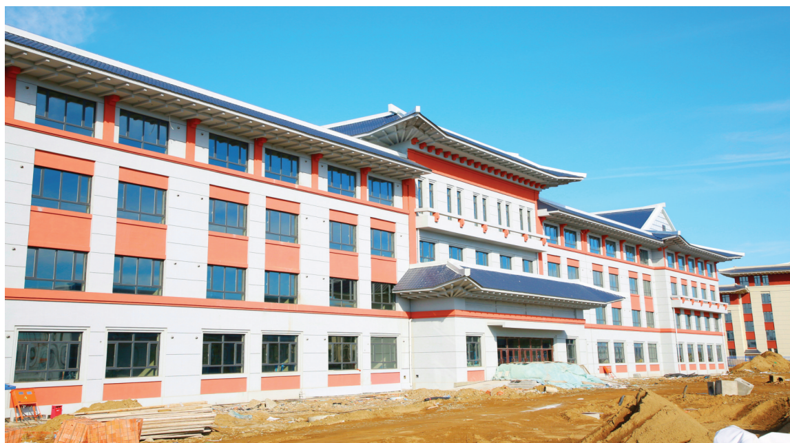
珲春市第五小学校新建项目进展顺利。目前,该项目已完成教学楼、风雨操场、食堂等主体封闭,外墙施工已完成,正在进行室内装饰及其他附属设施建设。图为项目现场。 本报记者 崔美玲 摄
