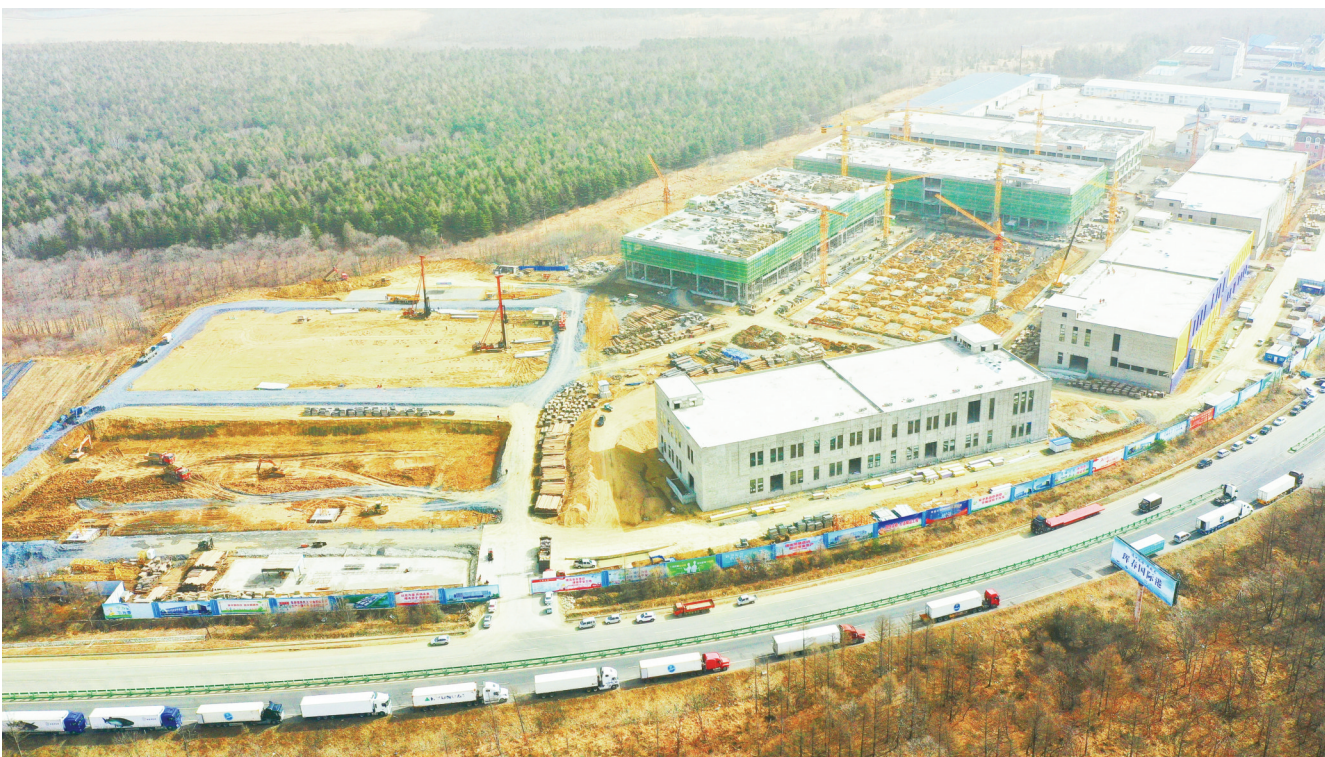
图为珲春中俄互市贸易现代物流集散中心项目建设现场。
