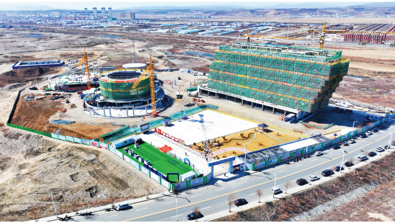
图为东北虎豹科普教育及资源展示设施项目建设现场。
