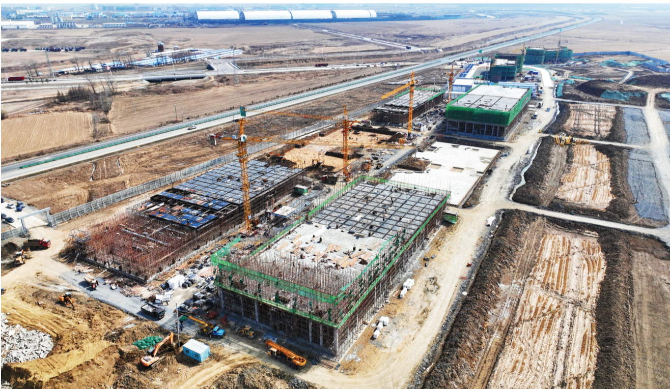
图为珲春市铁路国际物流园区项目建设现场。
