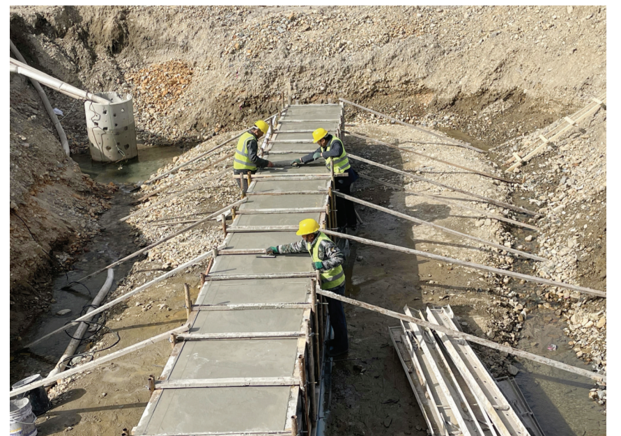
图为珲春海洋经济示范区口岸大路等道路排水系统改造项目施工现场。本报记者 崔美玲 摄
