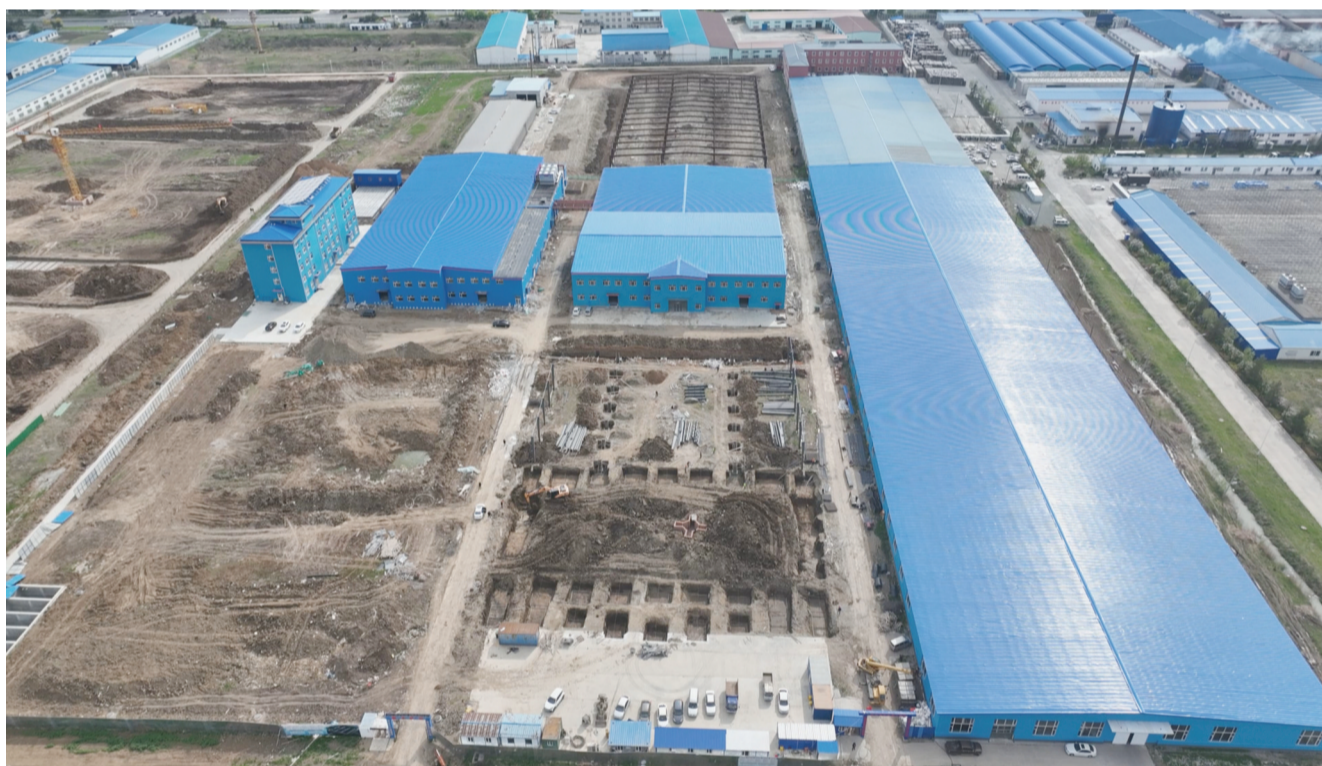
图为珲春兴阳水产有限公司三期、四期项目建设现场。
