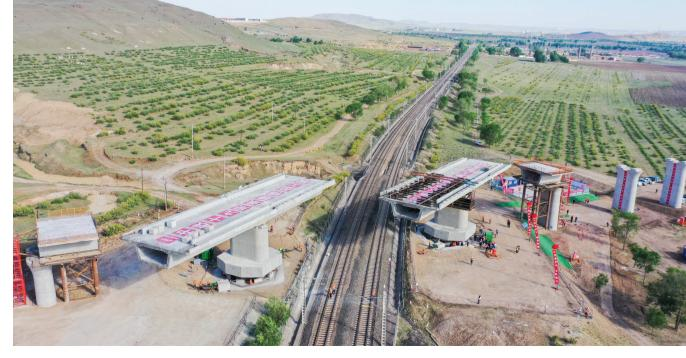
5月29日,集大原高铁跨京包铁路连续梁转体作业中(无人机照片)。
