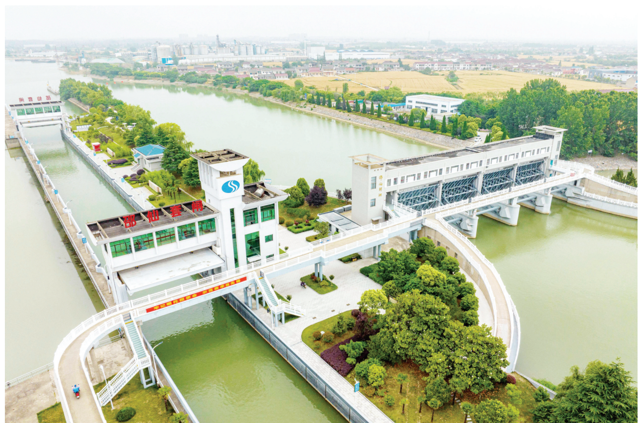
南水北调东线北延工程完成2022年至2023年度调水任务。这是6月1日拍摄的位于江苏省扬州市江都区的南水北调东线一期工程邵仙套闸、邵仙闸(无人照照片)。据悉,南水北调东线2022年至2023年度苏鲁省界调水于5月29日12时结束,共向山东省调水8.5亿立方米;南水北调东线北延应急供水工程5月31日20时完成2022年至2023年度调水任务,共向黄河以北调水2.77亿立方米。新华社发(任飞 摄)
