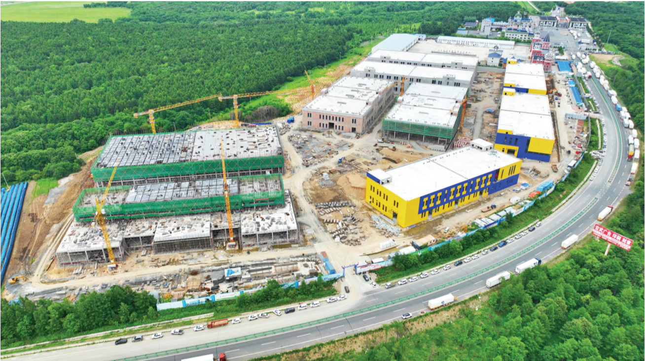
图为珲春中俄互市贸易现代物流集散中心项目建设现场鸟瞰。
