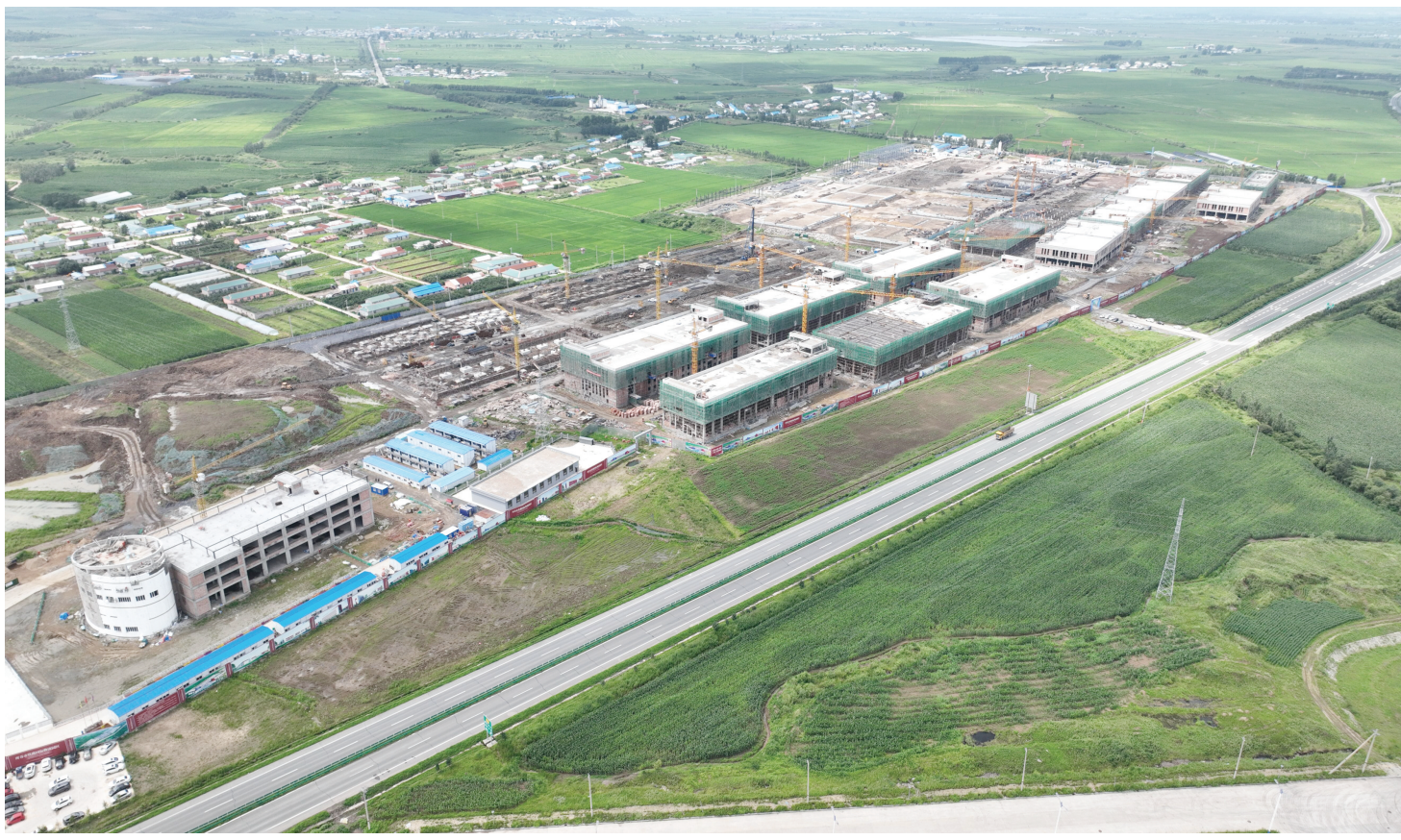
珲春市铁路国际物流园区项目进展顺利。项目计划总投资约12.3亿元,用地面积约41万平方米,建筑面积约25万平方米,主要建设34栋标准化物流厂房、1栋综合楼及配套附属设施等工程。图为项目鸟瞰。
