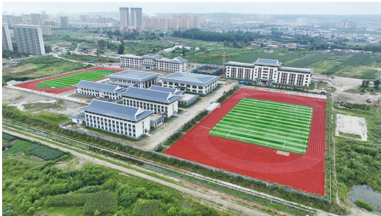
珲春市第一高级中学扩建项目、珲春市第五小学校项目工程鸟瞰。
