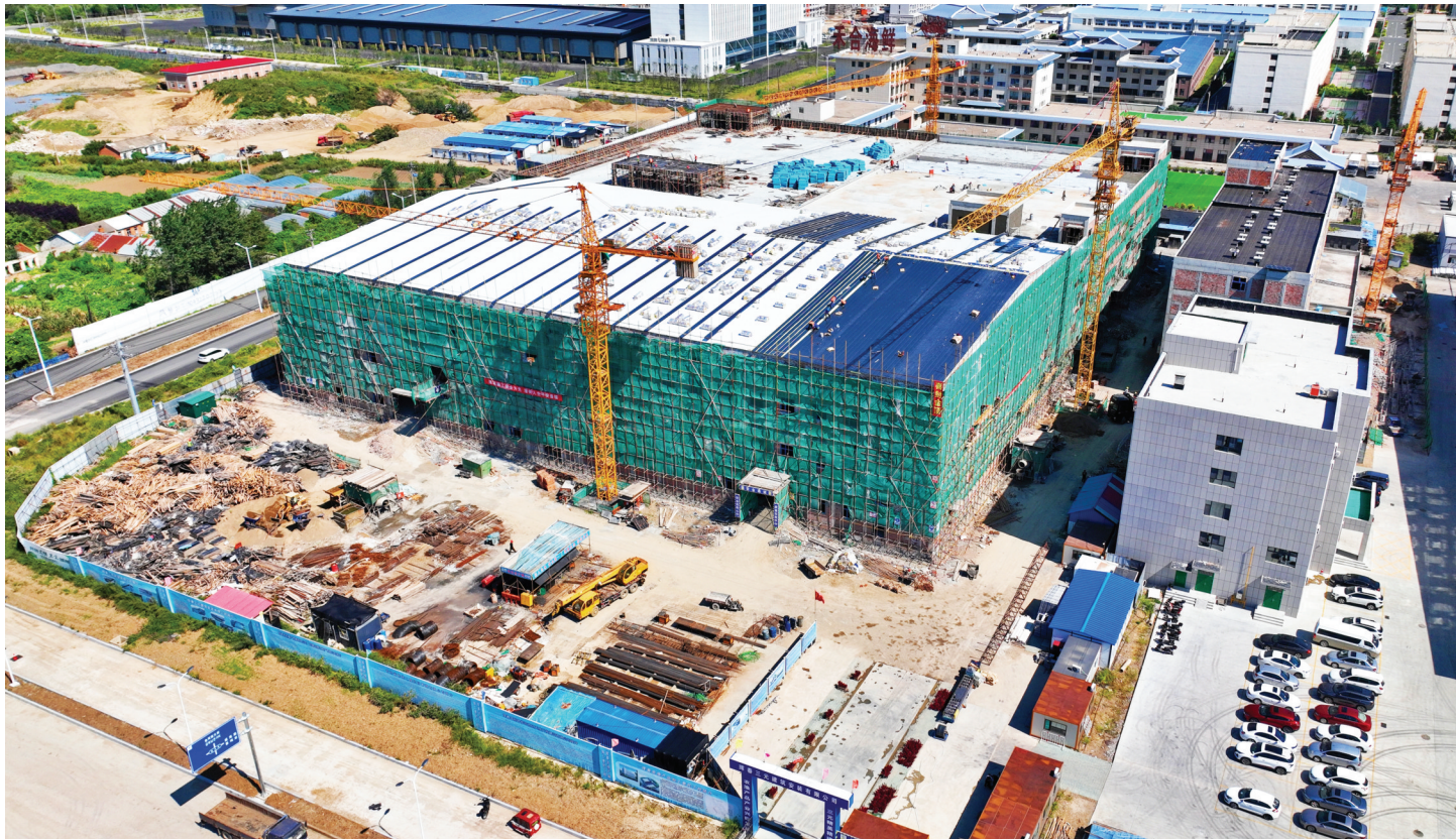
珲春农渔产品加工惠民工程项目进展顺利。项目总投资约2.14亿元,主要建设综合楼、加工车间、冷库及附属设施等工程。项目建成后,将完善全市农渔加工产业基础设施,为中小企业入驻创业和发展提供条件,促进农渔产品加工产业发展。图为项目鸟瞰。
