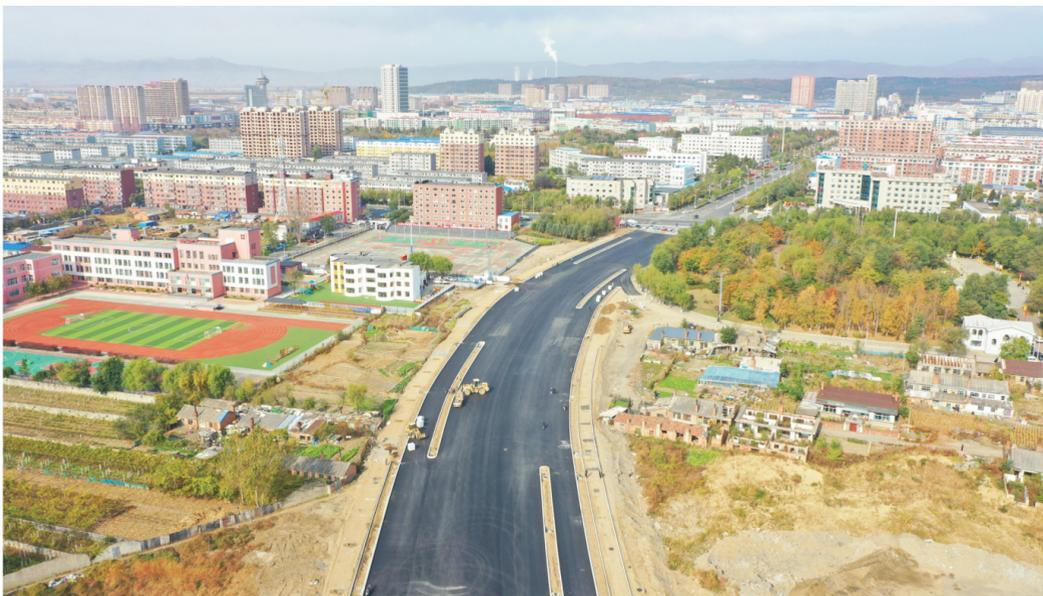
珲春市新安路连接河堤路工程项目进展顺利。项目全长983.847米,道路宽45米,为双向6车道,主要建设道路、污水、绿化等工程,预计今年11月完成路面工程并通车。图为项目现场鸟瞰。本报记者 鹿裕滨 摄
