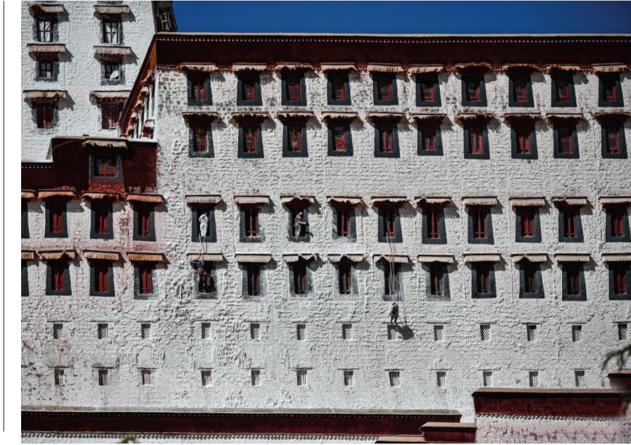
工作人员对布拉拉宫外墙喷洒涂料(10月18日摄)。
