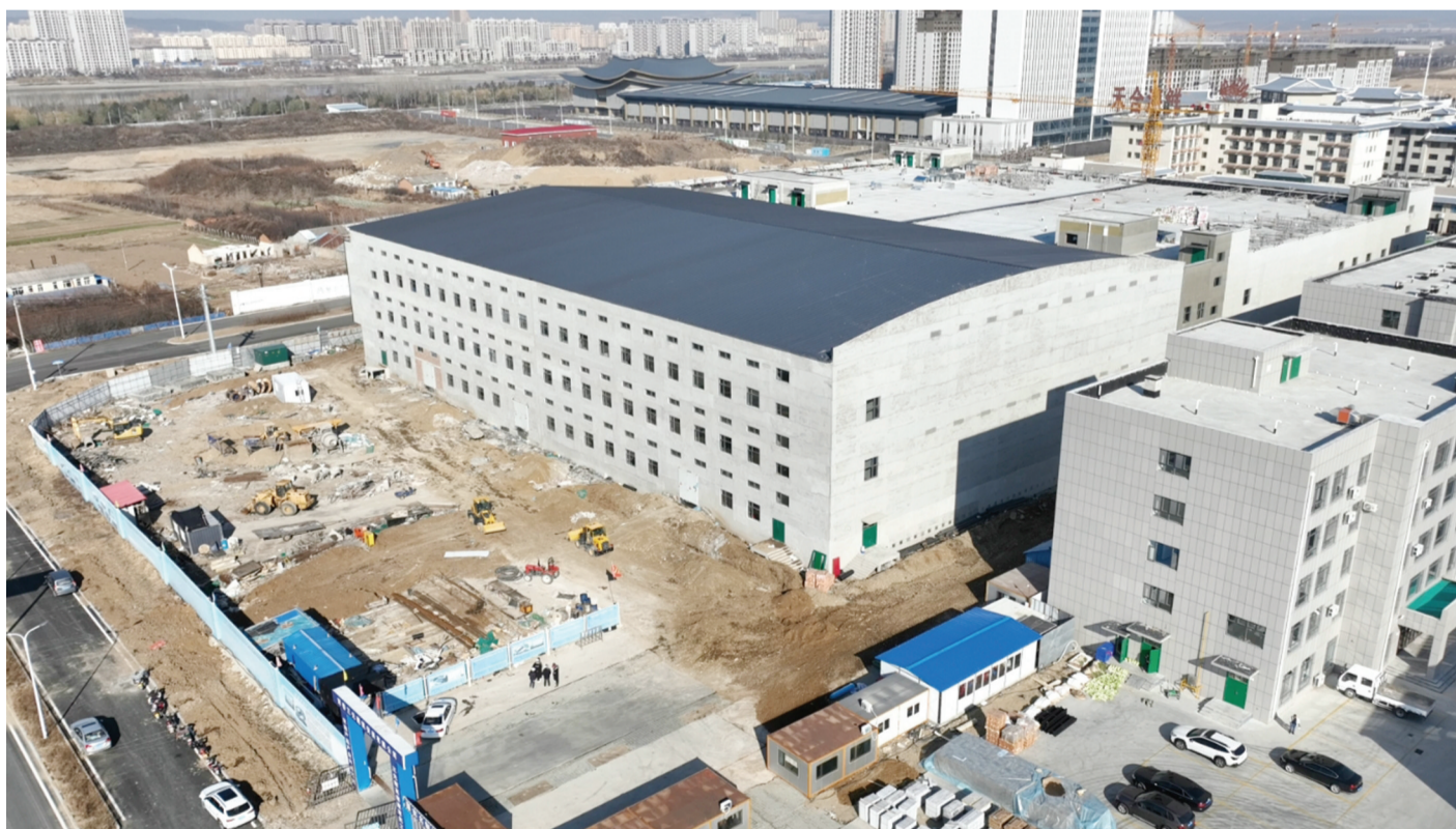
珲春市农渔产品加工项目进展顺利。项目总投资约2.14亿元,主要建设综合楼、加工车间、冷库及附属设施等工程。项目建成后,将完善全市农渔加工产业基础设施,为中小企业入驻创业和发展提供条件,促进农渔产品加工产业发展。图为项目鸟瞰。
