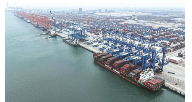
在广西钦州港码头,多艘海轮在卸货(3月1日摄,无人机照片)。今年以来,西部陆海新通道铁海联运各环节信息实现高效互通共享,集装箱通过码头自动化设备高效运转,形成方便、快捷的运输优势。据中国铁路南宁局集团有限公司统计显示:今年前两个月,西部陆海新通道铁海联运班列发送货物13.2万标箱,同比增长10%。 新华社记者 张爱林 摄
