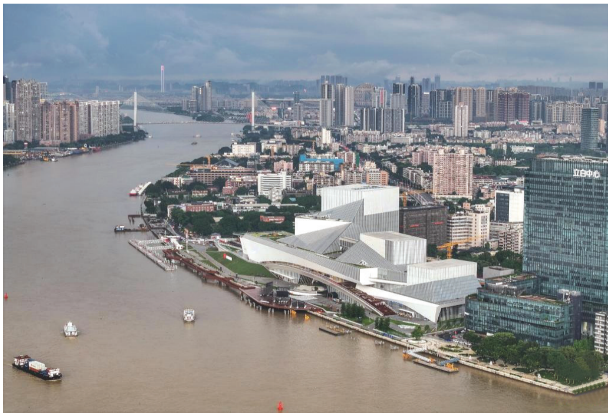
4月27日拍摄的白鹤滩大湾区艺术中心(无人机照片)。坐落于广州珠江白鹤滩的大湾区艺术中心将于4月28日正式启用,5月1日面向公众正式开放。白鹤滩艺术中心集广东美术馆、广东非物质文化遗产馆、广东文学馆于一体,是岭南文化的标志地、大众休闲目的地、湾区交流的“会客厅”。新华社记者 刘大伟 摄
