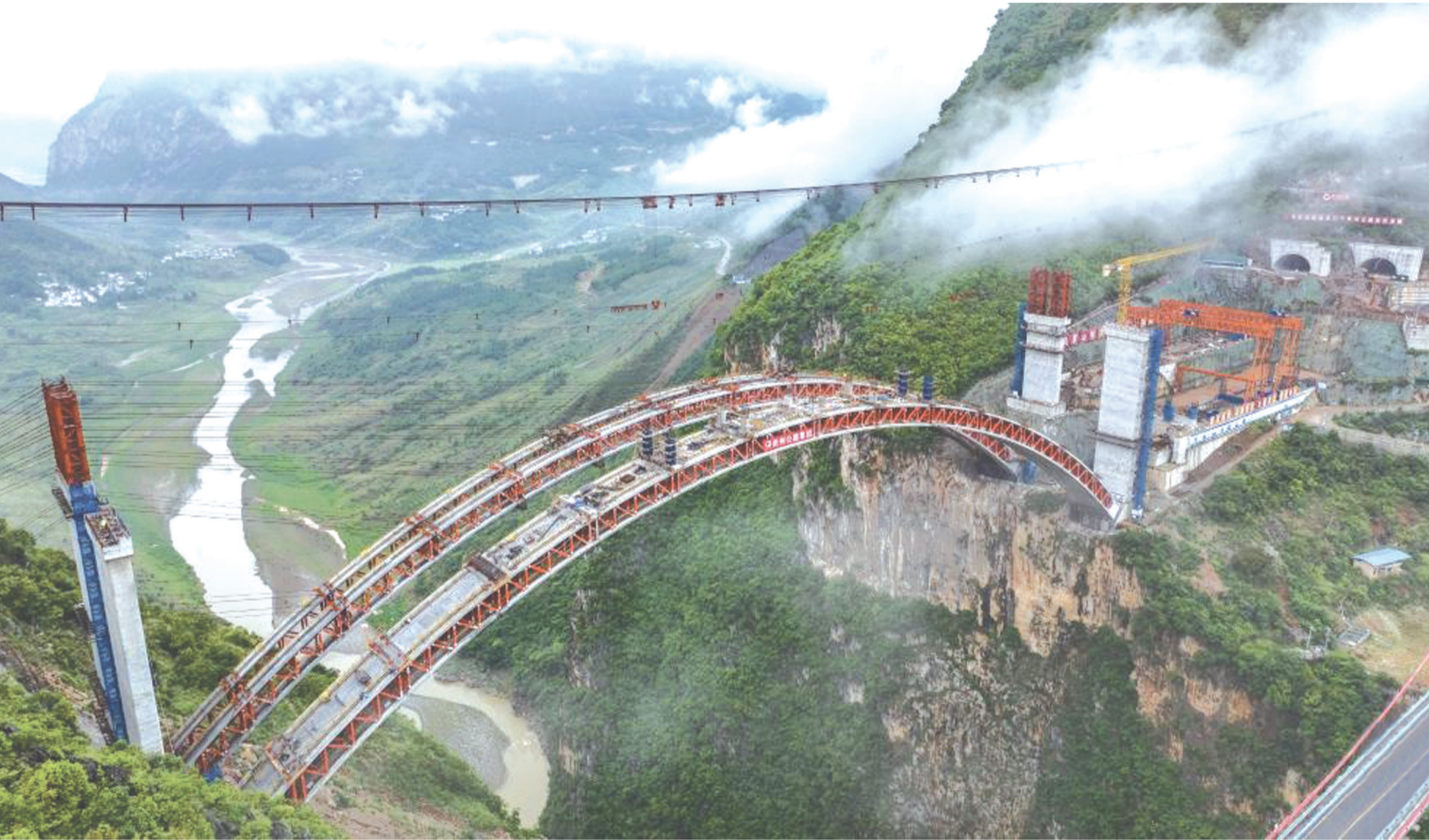
这是5月28日拍摄的正在建设中的纳晴高速乌蒙山大桥(无人机照片)。近日,纳晴高速乌蒙山大桥双幅主拱顺利实现合龙,乌蒙山大桥总体施工进度进入冲刺阶段。新华社记者陶亮摄
