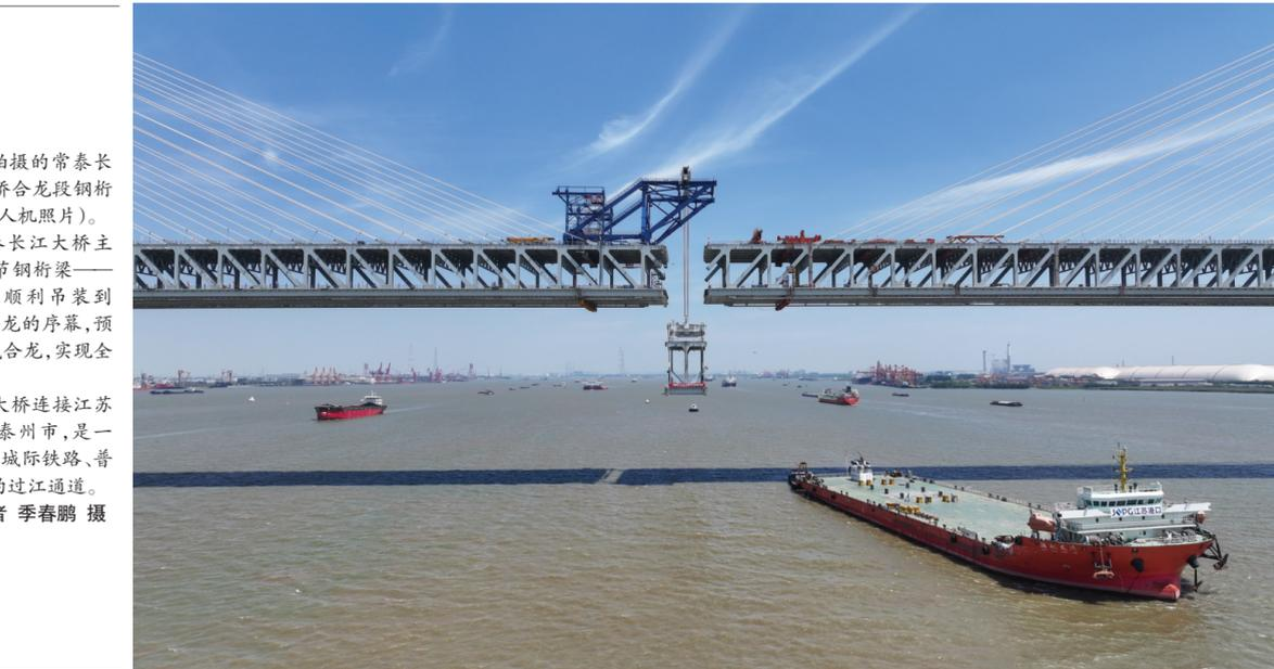
5月29日拍摄的常泰长江大桥主航道桥合龙段钢桁梁吊装现场(无人机照片)。
