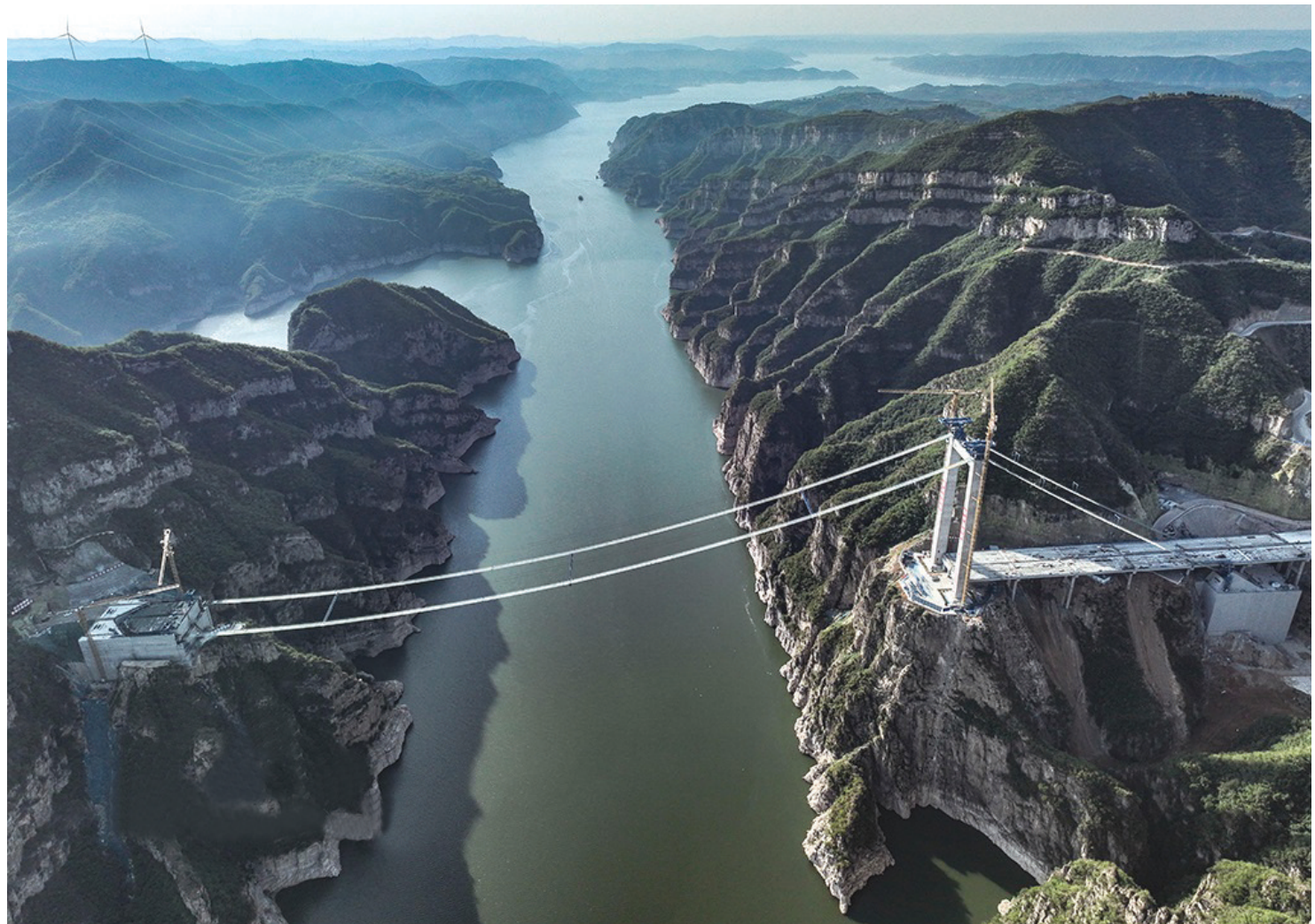
由中铁四局承建的济新黄河大桥是河南省济(源)新(安)高速公路的控制性工程,是世界首创的地铁式回绕缆索桥,同时也是世界上跨度最大的回绕缆索桥。随着日前大桥锚碇浇筑任务的完成,该桥全面进入上部结构施工阶段,索鞍安装及主缆索股牵引等工程正加紧施工。
